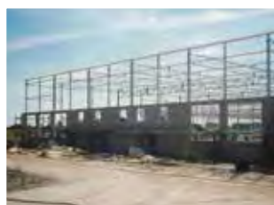
1994 - Bouw nieuwe serre
